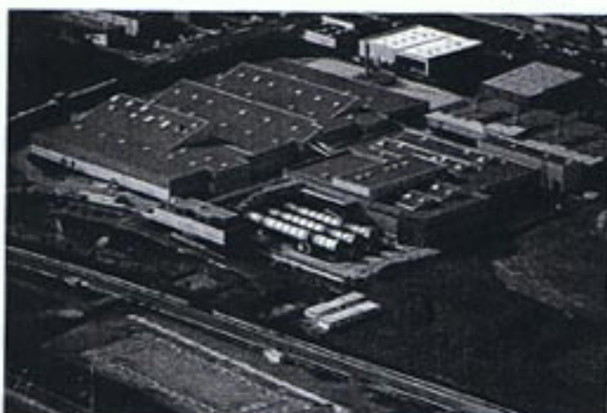
Exemple : vue d'ensemble de l'usine de prétraitement mécano-biologique de Montpellier
