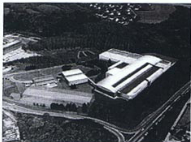
Exemple : vue d'ensemble de l'usine de prétraitement mécano-biologique et du centre de tri de Lorient
